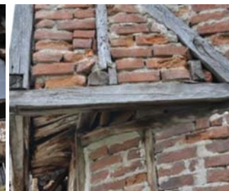
Şekil 18. Özgün Malzemelerin Yıpranmasına İlişkin Örnek
