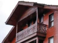
Şekil 6. Açık Çıkma Örneği
