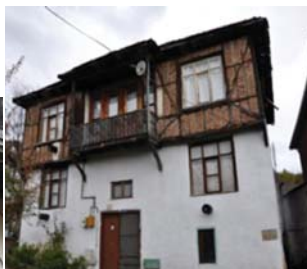
Şekil 12. Duvar Boşluklarında Değişim ve Bozulma Örneği
