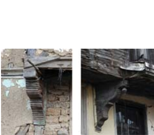
Şekil 11. Saraylı Geleneksel Konut Cephelerinden Payanda Örnekleri
