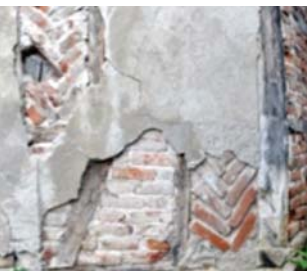
Şekil 15. Geleneksel Konut Cephelerinde Özgün Olmayan Uygulamalar
