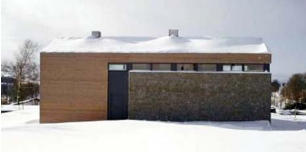
Şekil 16. Kır Evi Genel Görünüm ve Ahşap Duvar Kaplaması 3
