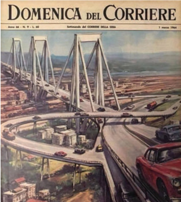
GÜNCEL: Tarihî Betonarme Köprüler Tehlikeli Mi? Morandi Köprüsü
