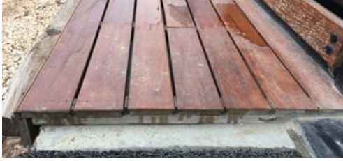
Şekil 37. 5E10 Masif Tasarım Mağazası, Zemine Oturan Döşemede Ahşap Kaplama Uygulaması (Hacı Aktar, 2017)
