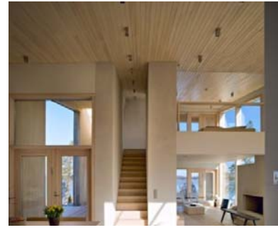
Şekil 15. Villa O Ahşap Malzeme İle Döşeme Alt Kaplama Uygulaması (URL-4, 2016)
