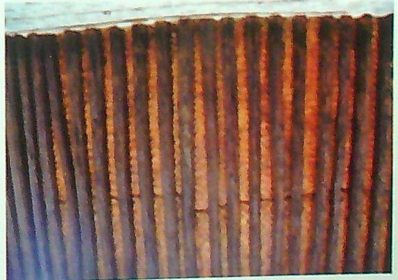
Şekil 15. Son Cemaat Yeri Üst Döşemesinde Ahşap Mertekler
