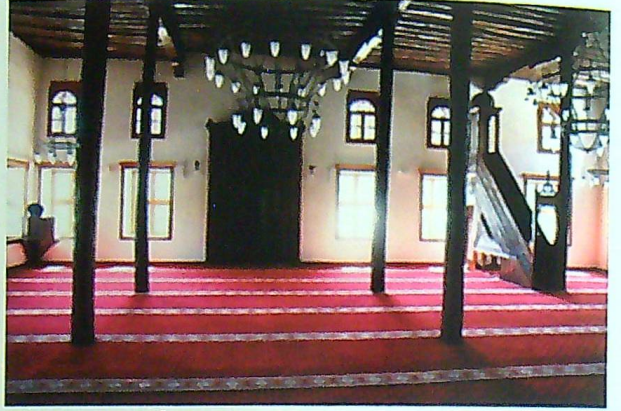
Şekil 18. İç Mekânda Ahşap Taşıyıcı Elemanlar (Web 2, 2017)
