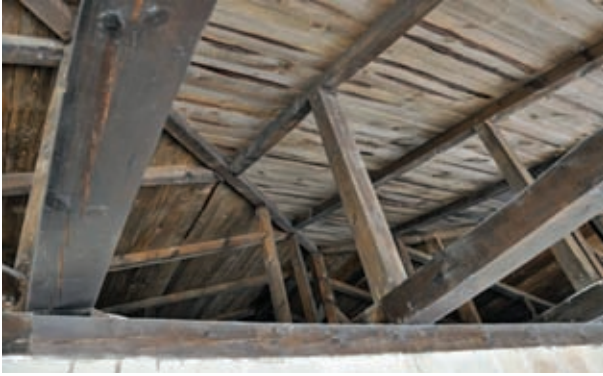
Şekil 11. Çatı Taşıyıcı Sistemini Oluşturan Ahşap Elemanlar, 2016
