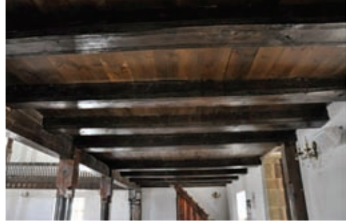
Şekil 24. Üst Mahfil Taşıyıcı Ahşap Elemanları, 2016
