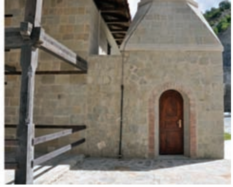
Şekil 19. Kuzey Cephesi Minare Kapısı, 2016
