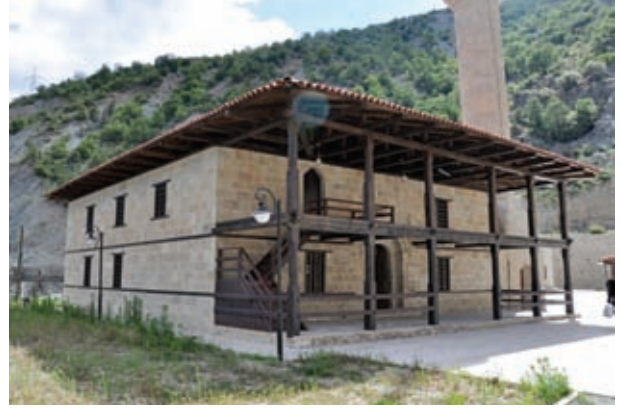
Şekil 2. Yeni Konumunda Zeytinlik Köyü Merkez Camii, 2016
