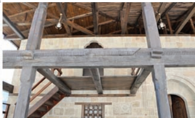
Şekil 10. Kuzey Cephesinde Ahşap Taşıyıcı Elemanlar, 2016
