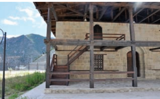
Şekil 9. Kuzey Cephesinde Ahşap İskelet Sistem, 2016
