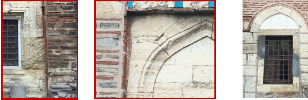
Fotoğraf 18. Taş Pencere Sövelerinde Görülen Bozulmalardan Örnekler
