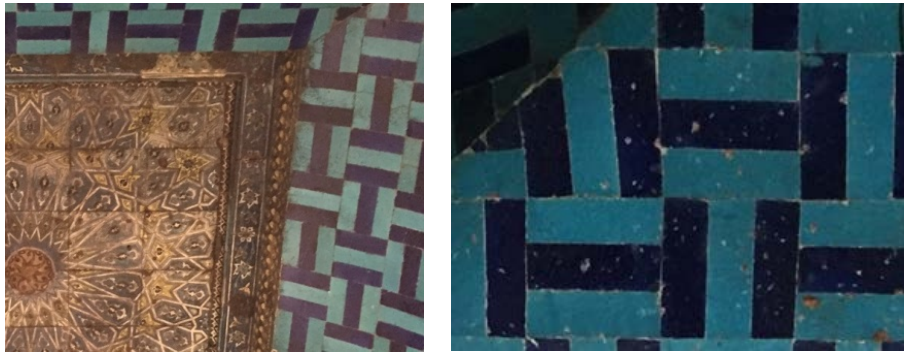
Fotoğraf 14. Tavan Çinilerinde Renk Değişimi ve Yüzey Kayıpları
