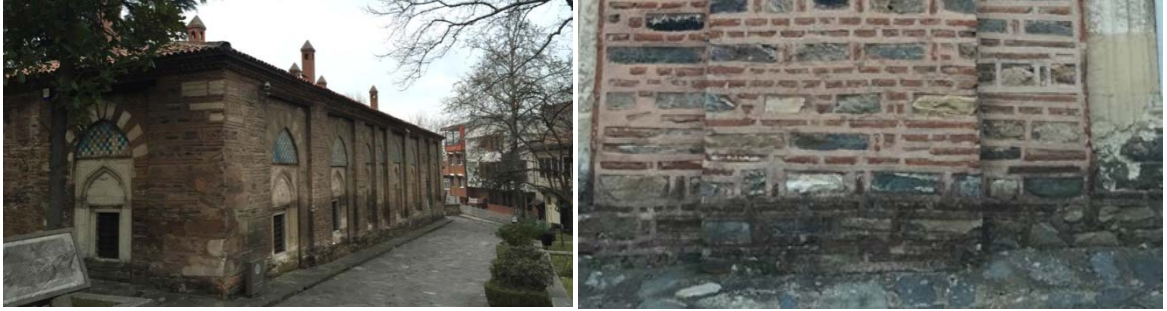
Fotoğraf 5. Duvarların Zemin Düzeylerinde Görülen Kirlilik Örnekleri
