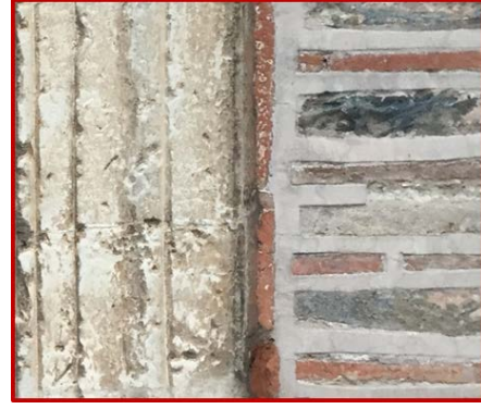
Fotoğraf 8. Tuğla Malzemede Görülen Çiçeklenme
