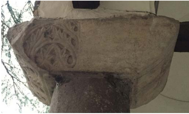
Fotoğraf 24. Revak Sütunu Üst Başlığında Parça Kaybı
