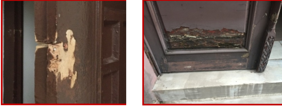
Fotoğraf 16. Kapı ve Görülen Bozulmalardan Örnekler
