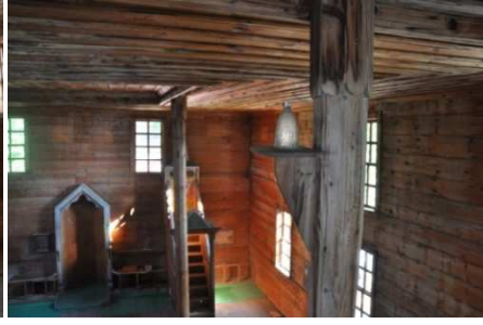
Şekil 11. Ahşap Dikmede Üst Başlık ve Fenerlik Detayı
