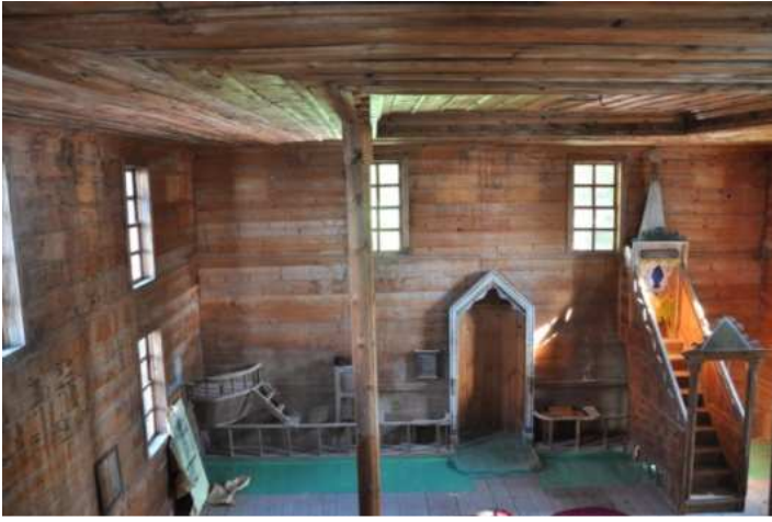
Şekil 12. Yapı Elemanlarında Ahşap Kullanımı
