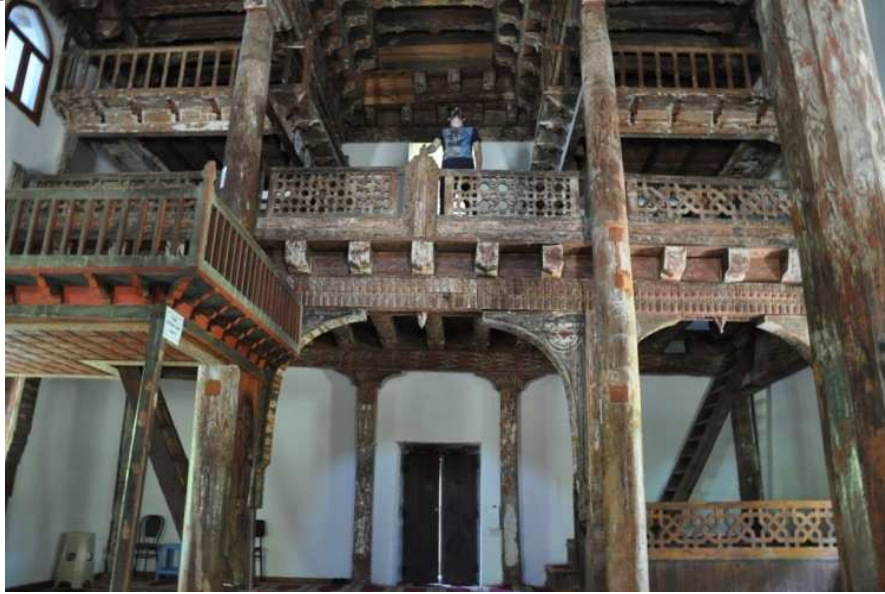
Şekil 18. Ahşap Kademeli Mahfil Sistemi
