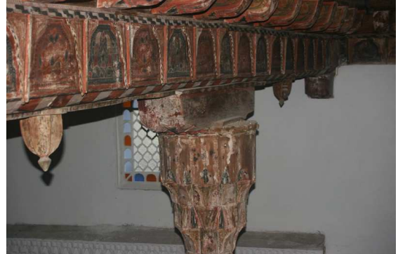
Şekil 15. Ahşap Kiriş Alt Yüzlerinde Pah ve Ahşap Sarkıtlar
