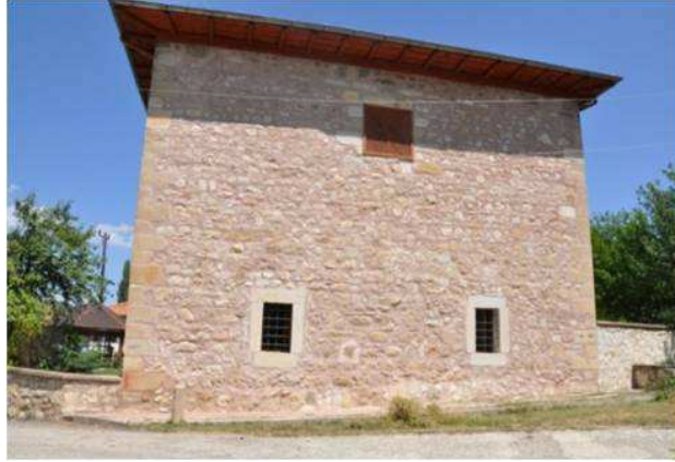
Şekil 4. Candaroğlu Mahmut Bey Camii Güney Cephesi
