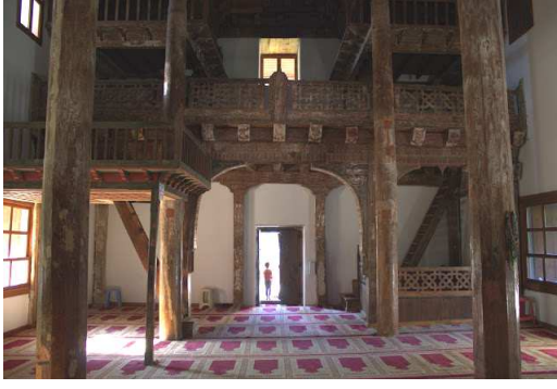
Şekil 10. Cami Hariminde Ahşap Dikmeler
