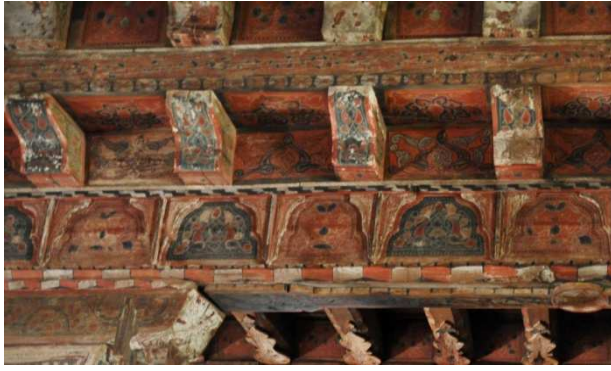
Şekil 16. Ahşap Bindirmeler
