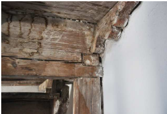
Şekil 19. Mahfil Döşeme Kirişi ve Dikme Birleşim Detayı
