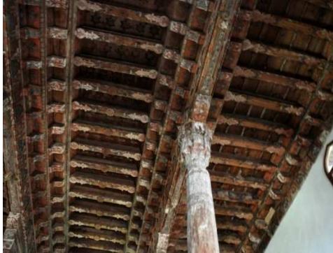
Şekil 14. Ahşap Dikme ve Tavan Kirişi Birleşimi
