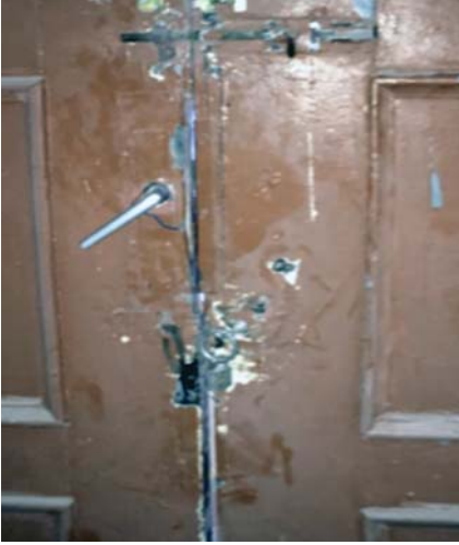
Şekil 22. Ahşap Kanat Birleşimlerinde Kırık
