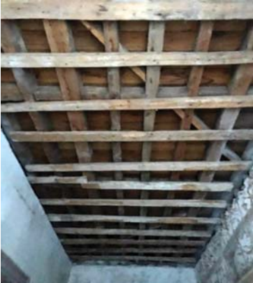
Şekil 2. Üst Kat Ahşap Döşemesi
