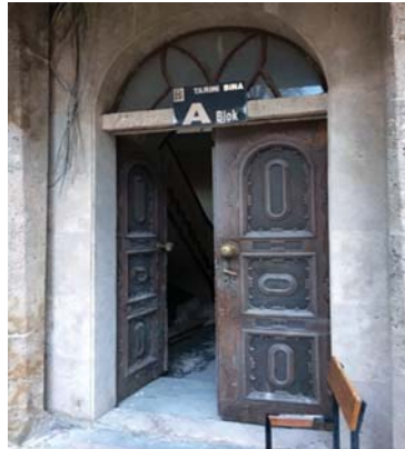
Şekil 6. Ahşap Doğramalı Kapı Örneği
