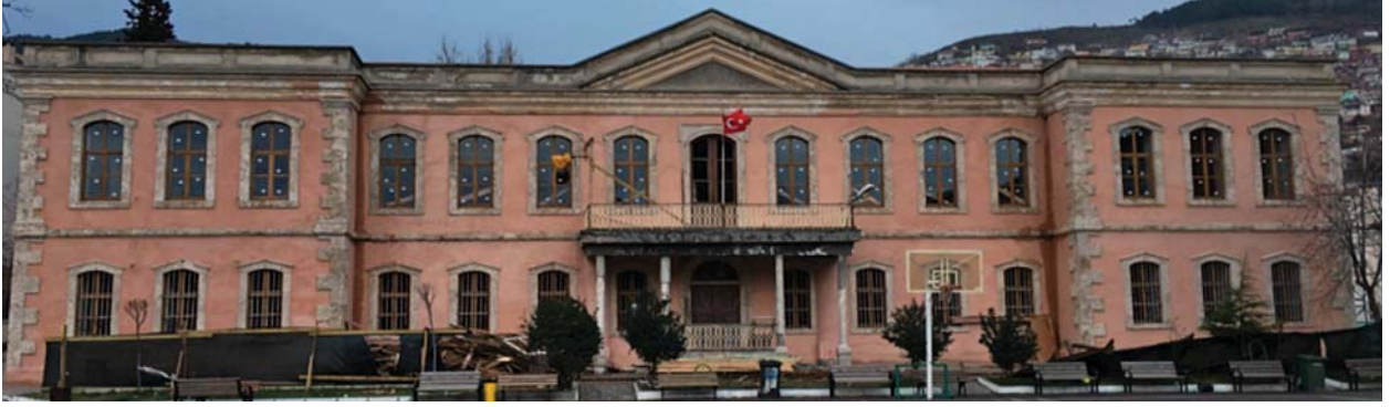
Şekil 8. Bursa Anadolu Erkek Lisesi Arka Cephesi
