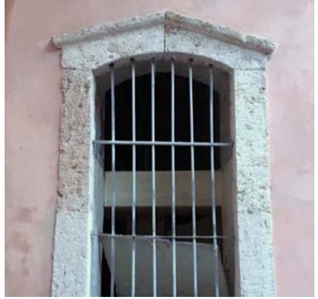
Şekil 20. Pencere Sövelerinde Bozulmalar
