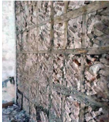
Şekil 3. Ahşap İskelet Arası Tuğla Dolgu
