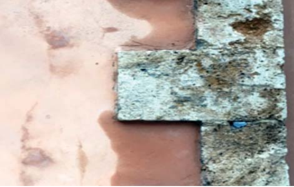
Şekil 14. Taş Sövede Yüzey Kaybı ve Renk Değişimi
