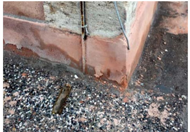
Şekil 12. Dış Duvarda Neme Bağlı Çiçeklenme
