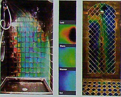
Şekil 7. Termokromik duvar kaplamalarının ıslak hacimlerde kullanımı (Web 5; 2016). Diag. 7. Use of thermochromic wall facings in wet spaces (Web 5; 2016).
