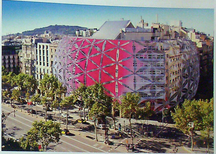
Şekil 4. Fotokromik tekstil malzemesi ile oluşturulmuş pasif gölgeleme sistemi (Web 3; 2015). Diag. 4. Passive shade system created using photochromic textile (Web 3; 2015).
