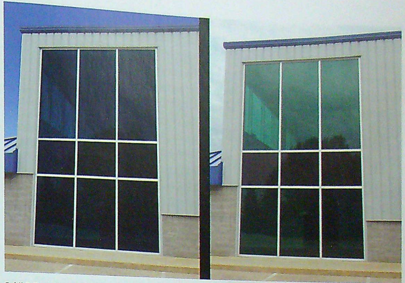
Şekil 8. Termokromik camın mimaride kullanımına bir örnek (Web 6; 2015). Diag. 8. Example of the use of thermochromic glass in architecture (Web 6; 2015).
