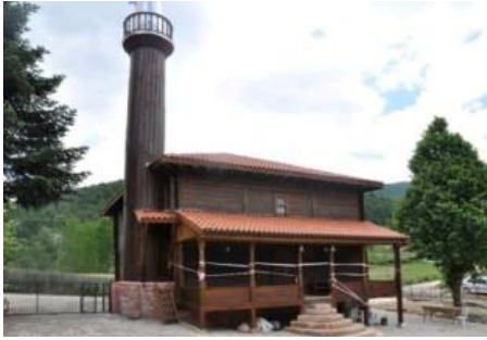
Şekil 2. İznik Elmalı Ahşap Camii Kuzey Yönünden Görünüm [4]
