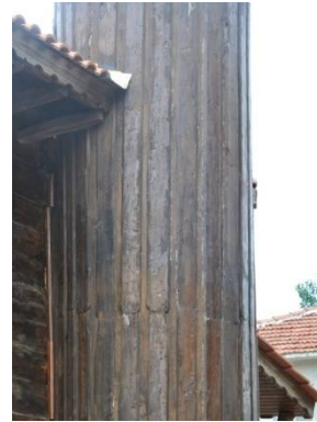
Şekil 24. Minarede Kullanılan Ahşap Elemanlar [4]
