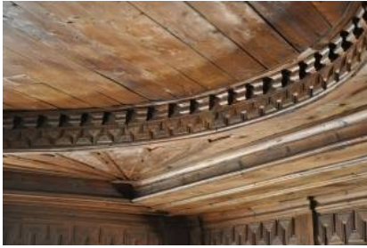
Şekil 13. Kademeli Ahşap Tavan Detayı [4]
