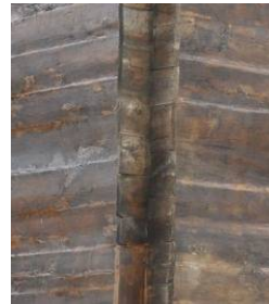
Şekil 5. İznik Elmalı Ahşap Camii Çantı Tekniği [4]
