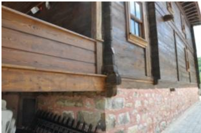
Şekil 4. İznik Elmalı Ahşap Camii Çantı Tekniği [4]
