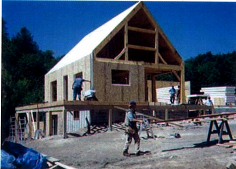
Şekil 14. Ahşap Panel Sistem Uygulaması [27]
