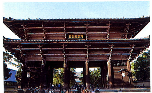
Şekil 9. Nara – Todaiji Tapınağı [22]
