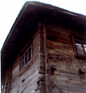
Şekil 6. Geleneksel Ahşap Yapıda Yığma Sistem [19]
