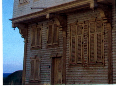
Şekil 18. Mudanya'da Geleneksel Bir Konutta Ahşap Cephe Kaplaması Örneği, 2013. [34]
