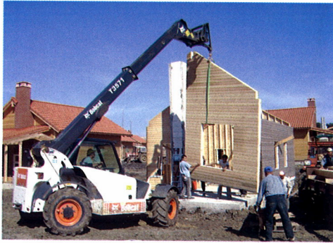
Şekil 13. Ahşap Panel Sistem Uygulaması [26]
