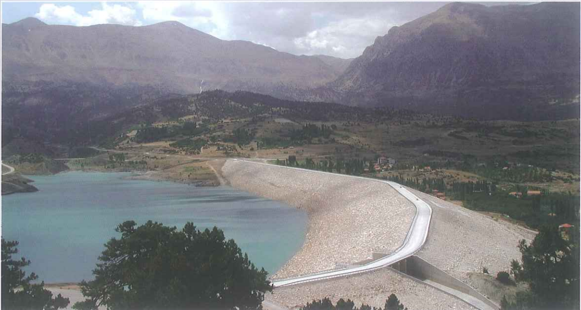
Çayboğazı Barajı ve Tesisleri İnşaatı / Antalya
