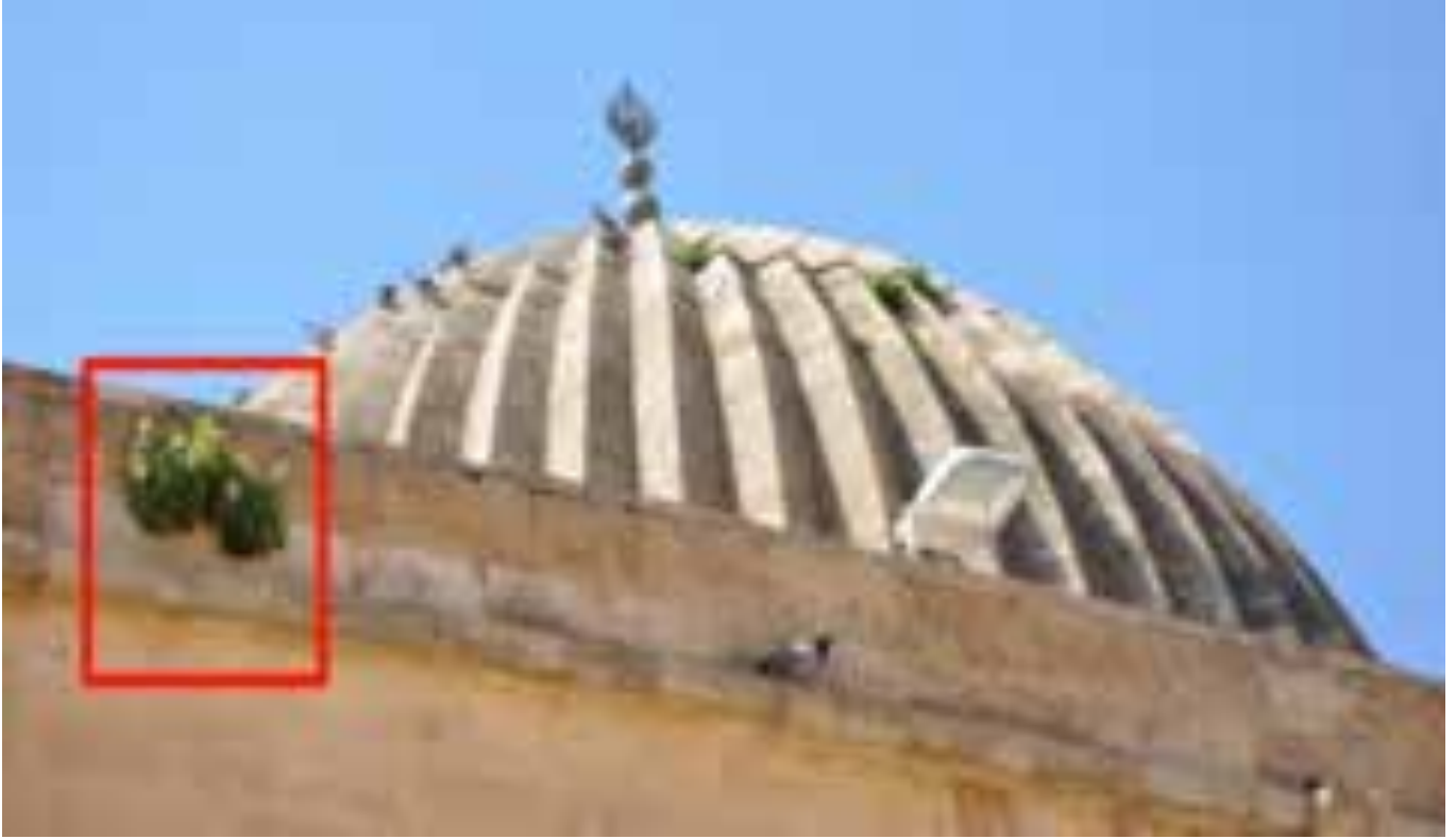
Şekil 39. Silmede Bitki Oluşumu
