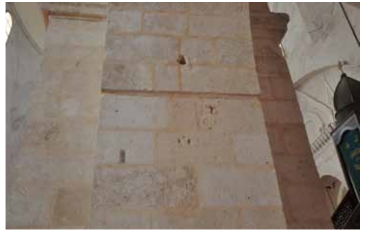
Şekil 15. Ulucami İç Mekân Tek Taşıyıcısında Oyuklanma
