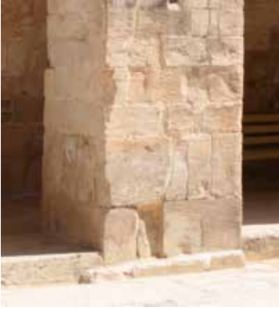
Şekil 11. Yüzey Kaybı (a)
