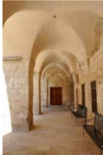
Şekil 27. 6 Numaralı Mekânda Çapraz Tonz
