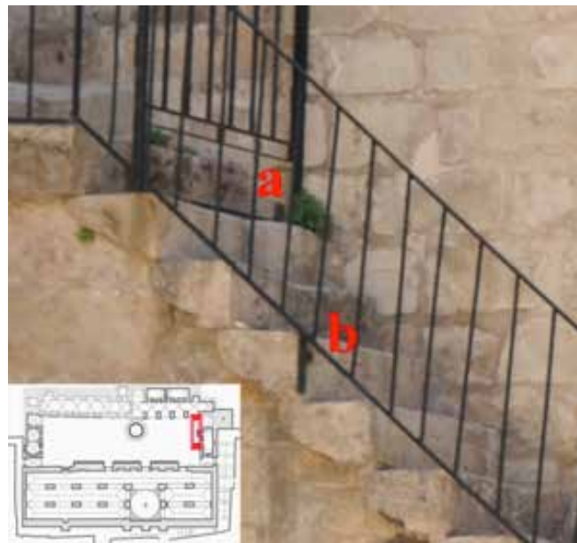
Şekil 35. Merdivende Bitki Oluşumu (a) ve Aşınma (b)
