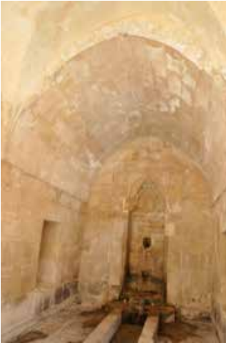
Şekil 26. 3 Numaralı Mekânda Çapraz Tonz
