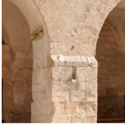
Şekil 12. Boşluk-Delik Oluşumu (b)
