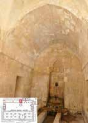
Şekil 30. Tonozlarda Çiçeklenme ve Renk Değişimi
