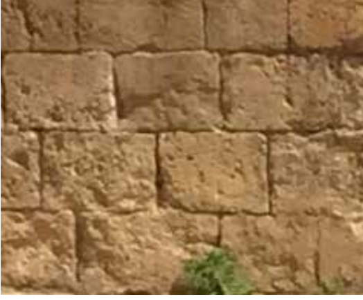
Şekil 16. Yüzey Kaybı ve Oyuklanma
