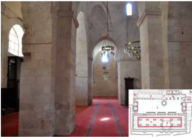
Şekil 14. Ulucami'nin İç Mekânında Bulunan Tek Taşıyıcılar
