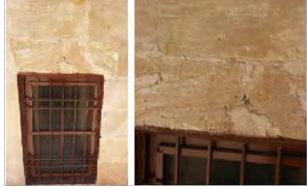
Şekil 8. Duvarda Kavlanma
