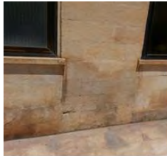
Şekil 9. Duvarda Derz Boşalması
