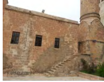
Şekil 12. Ön Cephede Çiçeklenme
