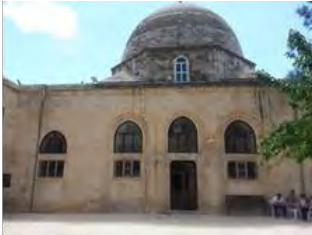
Şekil 11. Kubbede Kabuk Oluşumu
