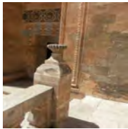
Şekil 2. Korkulukta Yüzey Kaybı
