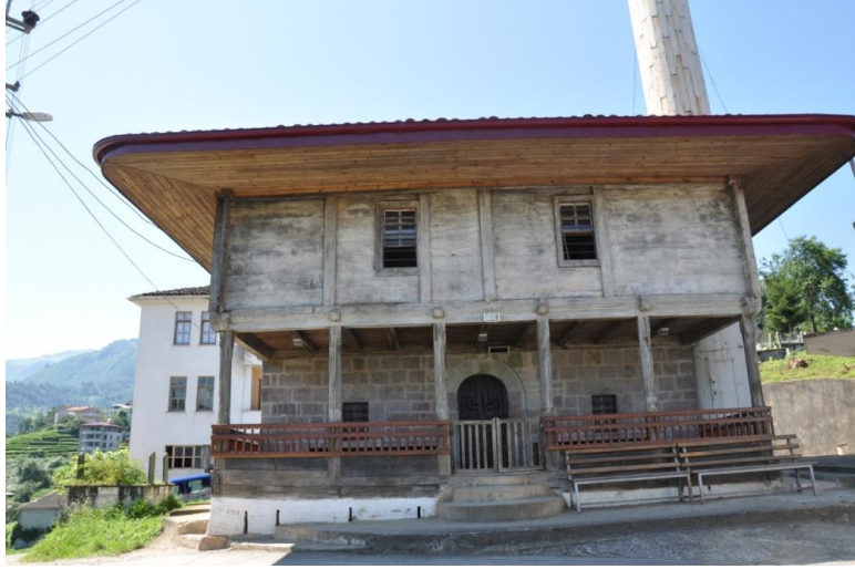
Şekil 8. Of Bölümlü Mithat Paşa Camii'nde Ahşap Kullanımı
