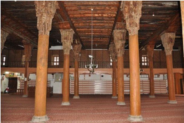
Şekil 3. Afyon Ulucamii'nde Ahşap Taşıyıcılar
